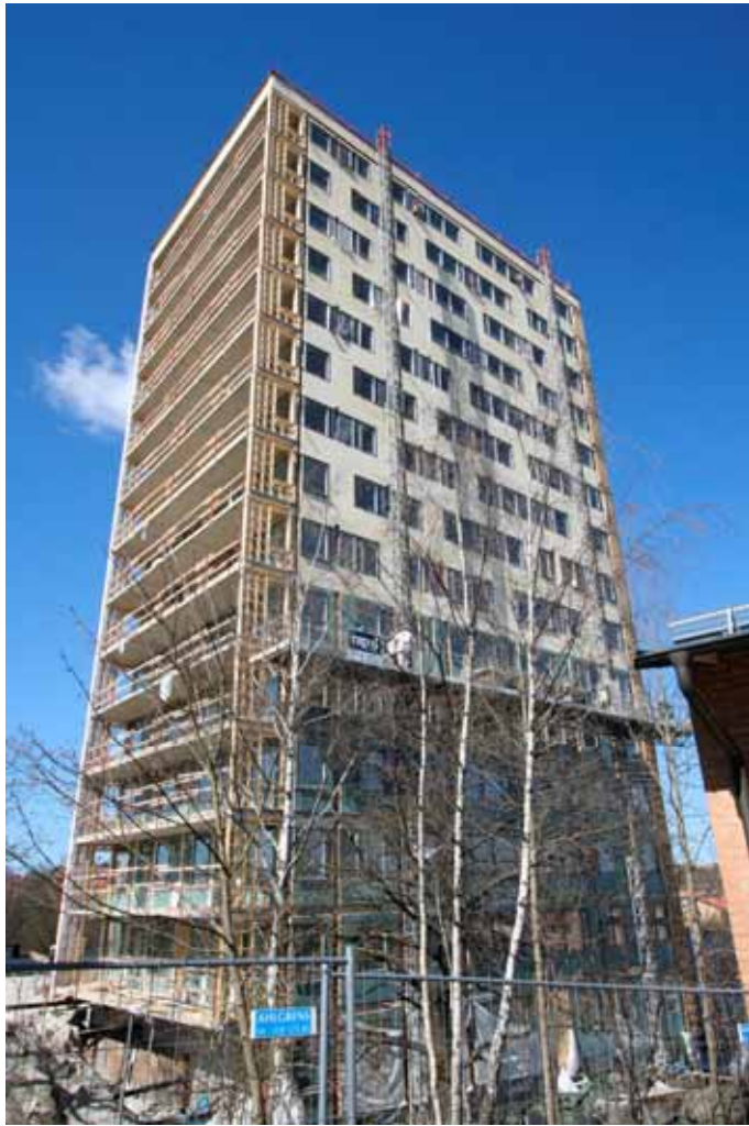
Bostadshus under bygge vid Brommaplan, Bromma
