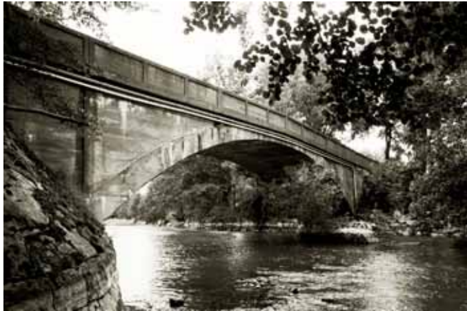
Betongbro i Vrena, Södermanland
